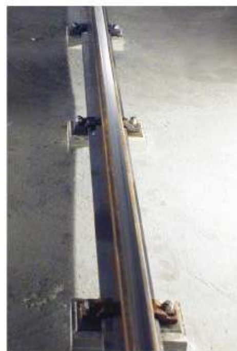
Después: imagen de un raíl tratado con protección contra el desgaste SPC®
