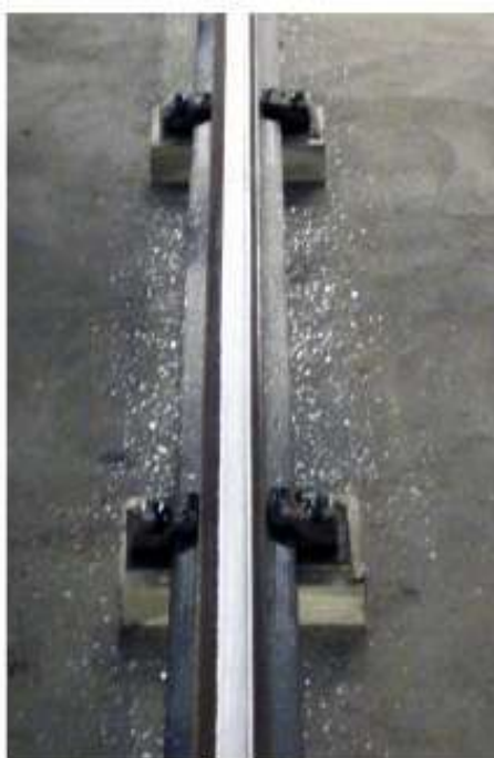
Antes: imagen de un raíl sin tratamiento
