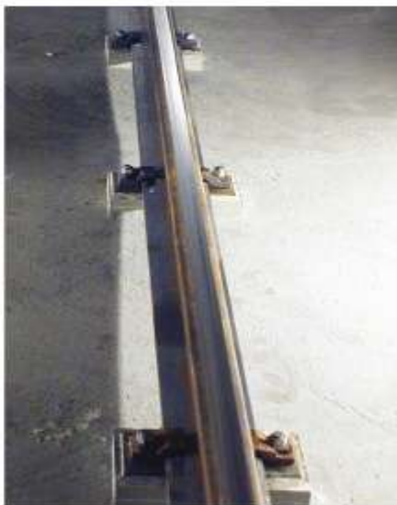
Después: imagen de un raíl tratado con protección contra el desgaste SPC®
