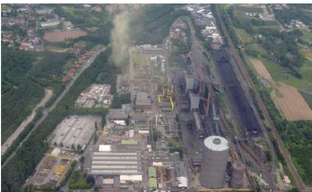
Bottrop Aplicación en grúa de planta de coque.
